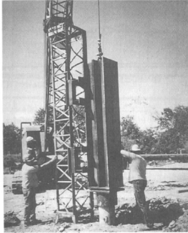
Figura 4 Prueba de Carga Dinámica (PDA)
