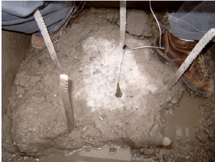
Figura 10 Limpieza de la cabeza del pilote y ubicación del acelerómetro
