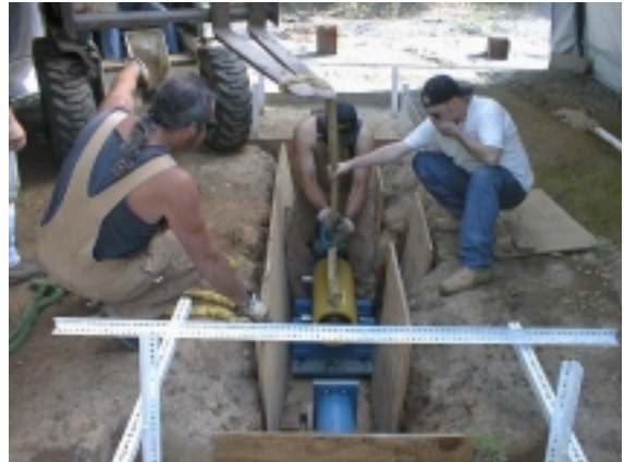
(d) Installing hydraulic ram in loading trench.
